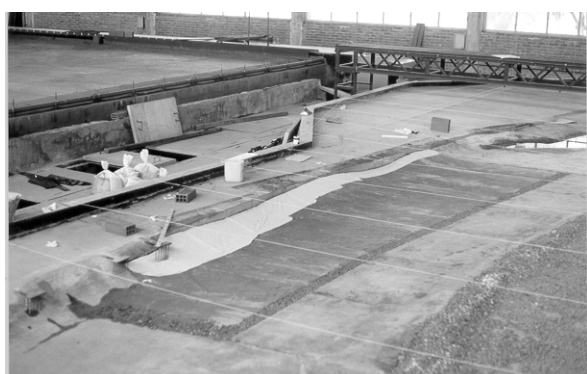
Figura 4. Ensayo con protección (Filtro)
