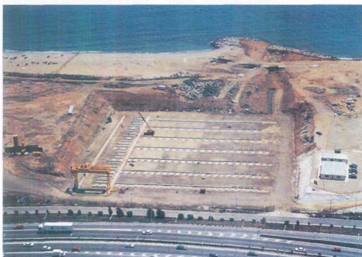
Figura 16. Terreno destituido al parque de tubos en las inmediaciones de la depuradora.
