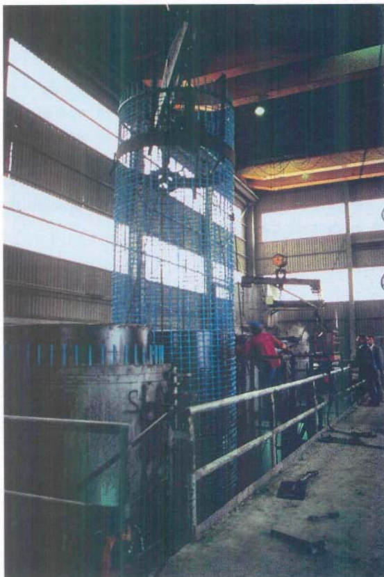
Figura 13. Introducción de las armaduras.
