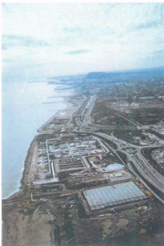
Figura 1. Vista aérea de las obras y de la planta depuradora. Al fondo, litoral de la ciudad de Barcelona.
