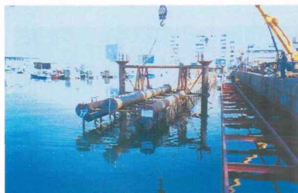
Figura 31. La estructura en el momento de ser transportada.
