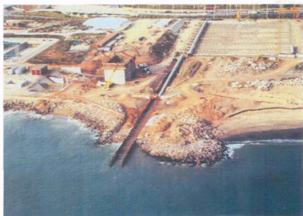
Figura 35. Tiro de los últimos tramos de la tubería
