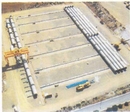
Figura 7. El parque de tubos.
