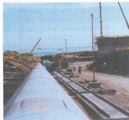
Figura 8. La rampa de lanzamiento.
