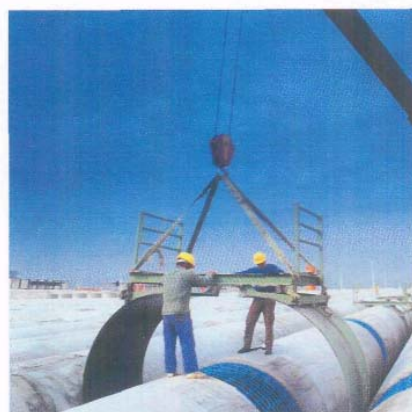
Figura 21. Hormigonado de las conexiones entre tubos.
