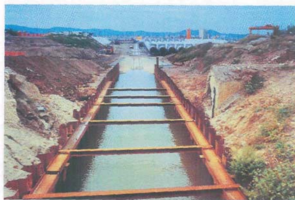
Figura 34. Rampa de lanzamiento protegida con tablestacas.
