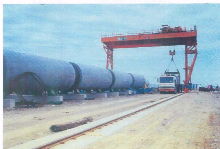
Figura 17. Llegada de los tubos procedentes de la fábrica y colocación en el parque de tubos
