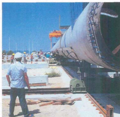
Figuras 22 y 23. Sistema hidráulico para el desplazamiento de los tramos.
