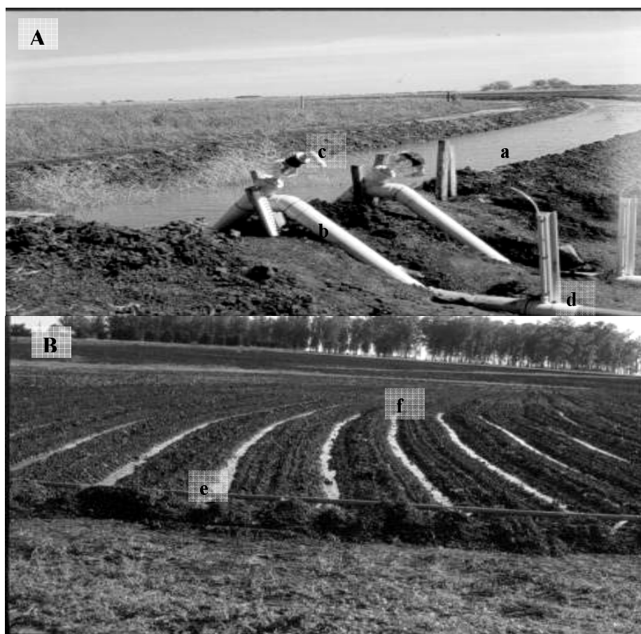
Figura 3. Equipo para riego por surcos. A) Detalle de toma de agua. a - canal principal, b - sifón PVC DN 110, c - bomba de vacío, d - tubería de conducción B) Detalle de aducción. e - tubería de riego de PVC con orificios, f - surcos de riego en contorno
