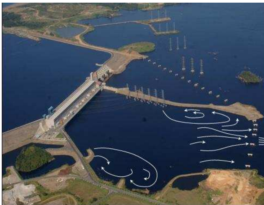
Figura 7. Líneas de corriente observadas en el prototipo
