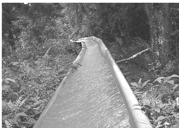
Figura 3. Canaleta de prueba.
