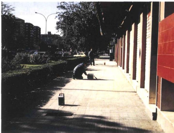
**Fotografía 2.** Detección práctica de fugas en la acera mediante correlación acústica (gentileza de Aguas de Valencia S.A.)
