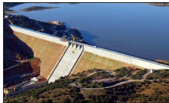
Figura 1. Presa de La Breña II.
