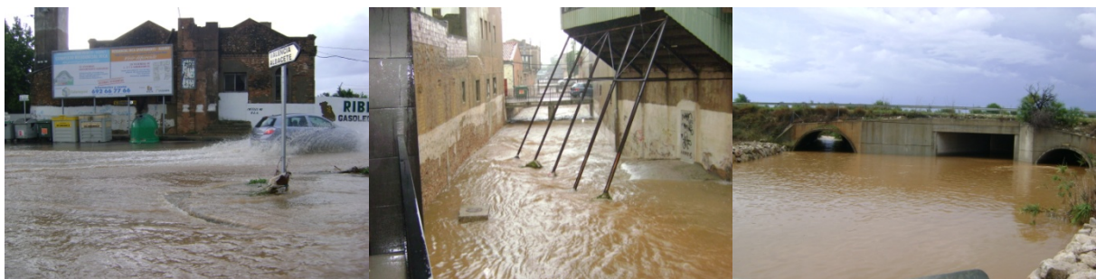
Figura 2 Barranco del Señor. Calle Pintor Velázquez. Barranco de la Forca. Núcleo urbano de Alginet. Obras drenaje A-7. Confluencia Barrancos Señor y Forca.
