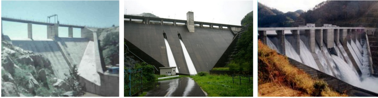
Figura 2 De izquierda a derecha, presas de Hammam Grouz (Argelia), Atagi y Tomada (Japón)
