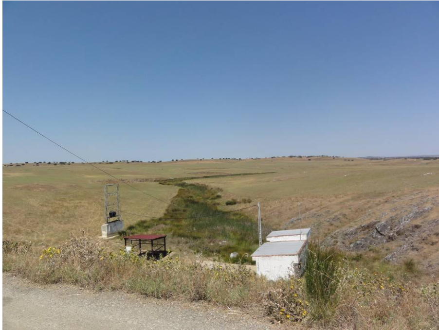
Figura 4 Vista aguas abajo desde cornación de la presa sobre el arroyo Cuncos.
