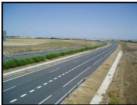
Figura 2 Ejemplo de afección a pie de balsa no reflejada en la cartografía oficial 1:10.000. Un camino rural pasa a ser una autovía.
