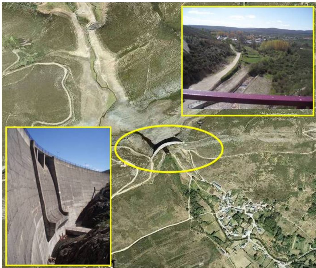
Figura 1 Ejemplo de presa que puede ser clasificada en categoría A mediante juicio ingenieril.
