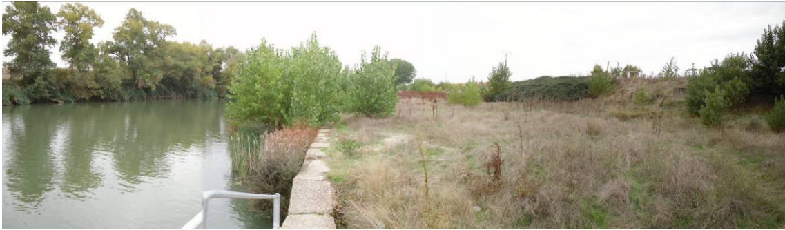
Figura 7 Vista de la margen derecha del cauce aguas abajo del azud.
