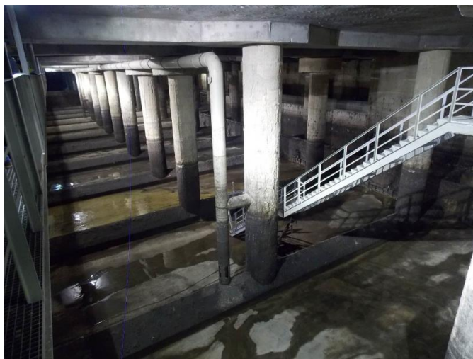
Figura 12 | Vista del interior de la zona 1 del estanque con los carriles de limpieza.
