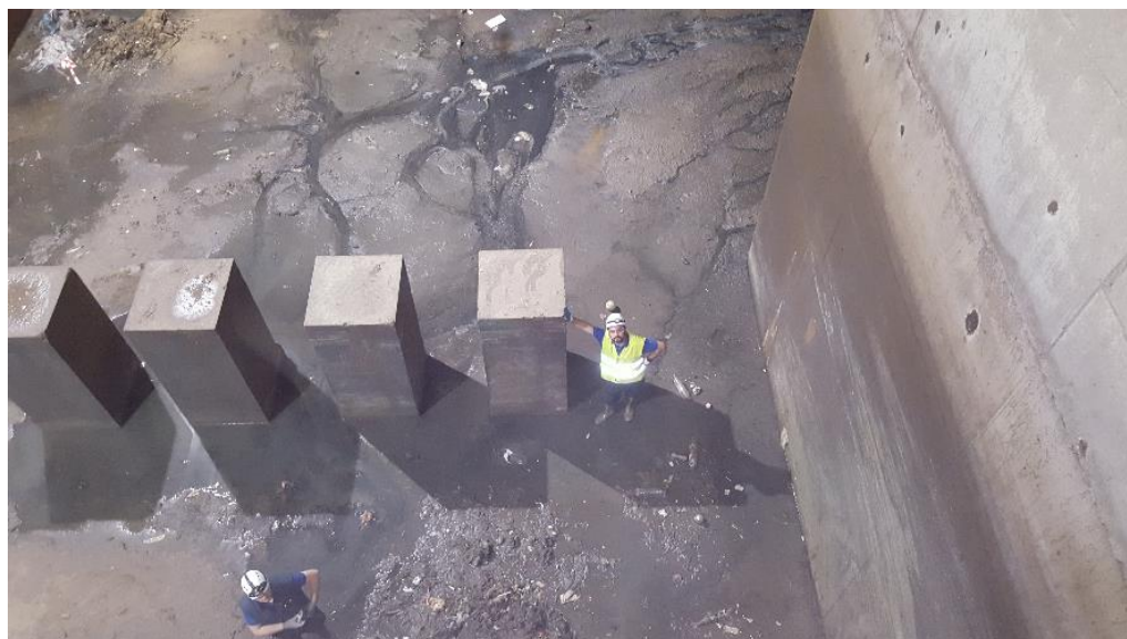
Figura 16 | Dados de hormigón para disipar energía. Zona de toma de muestras de agua que será conducida al tanque de tormentas de Arroyofresno.
