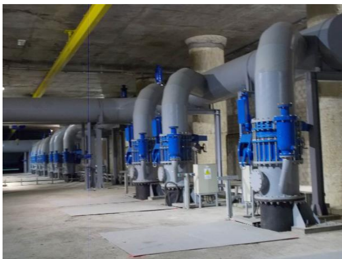
Figura 13 | Vista de las tuberías de impulsión en la planta de servicios.
