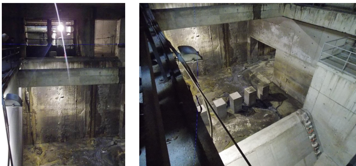
Figura 7 | Aspecto general de la cámara de disipación de energía, llegada del colector de Pinos y embocadura al colector hacia el tanque de tormentas de Arroyofreso. Se aprecia el pequeño azud con perfil Creager.
