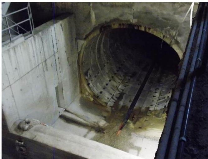
Figura 8 | Vista de la obra de entrada al túnel – nuevo colector de Arroyofreso.
