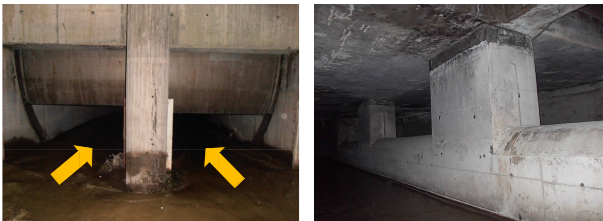
Figura 7 | Compuertas TAINTOR aguas abajo de la zona de aliviaderos, que se muestra a la derecha
