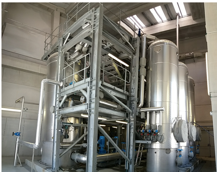
Figura 9. Hidrólisis Térmica instalada en la nueva EDAR de Lagares
