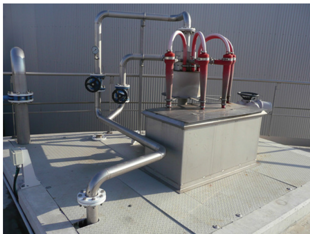
Figura 10. Sistema de separación de biomasa instalado en el reactor Demon® de la EDAR de Lagares
