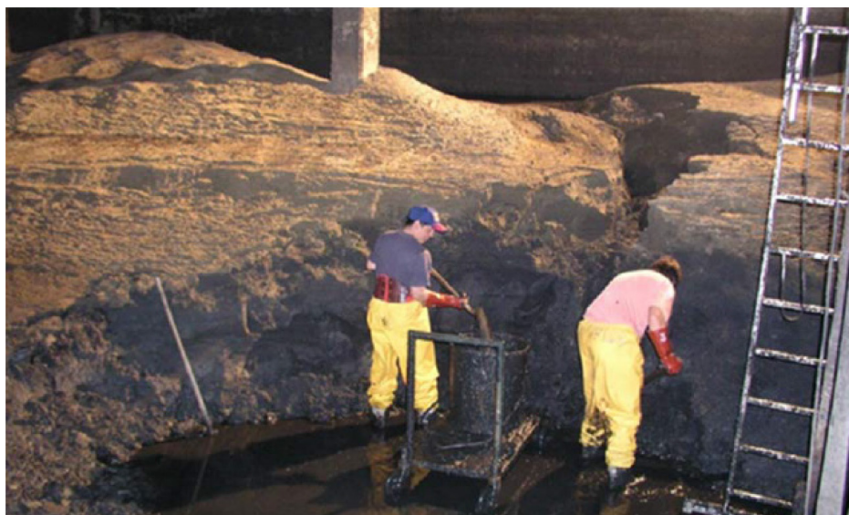
Figura 5 | Labores de retirada de arenas del interior de los digestores anaerobios de la EDAR actual
