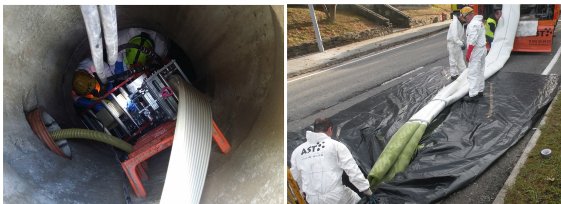
Figura 10 | Sistema de rehabilitación SWL. Sistema de rehabilitación mediante manga polimerizada in situ
