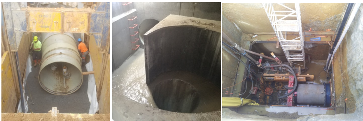
Figura 9 | Imagen de la instalación en zanja de tubería de PRFV. Imagen del interior de un pozo vórtice. Imagen del pozo de ataque de uno de los microtúneles
