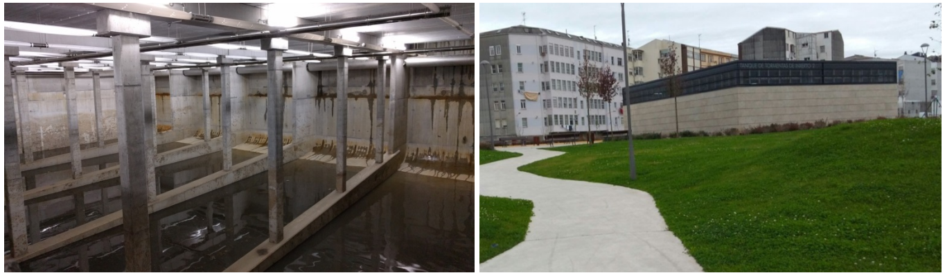
Figura 7 | Fotografías del interior de la cámara de retención del tanque de tormentas de Inxerto 2 y del exterior de su edificio de explotación
