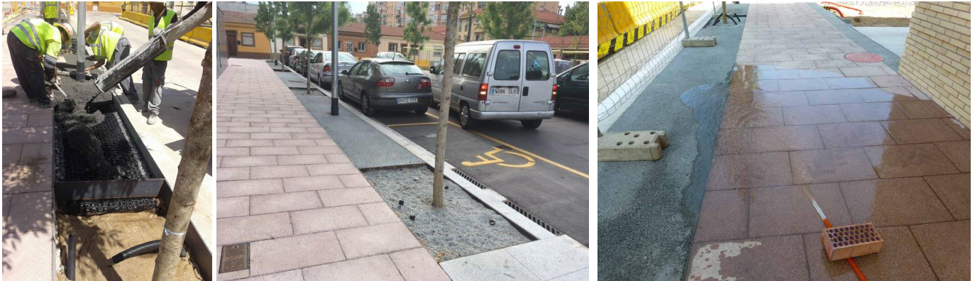
Figura 5. Pavimento permeable sobre celdas de polietileno y éstas sobre suelo estructural en las alineaciones de arbolado.
