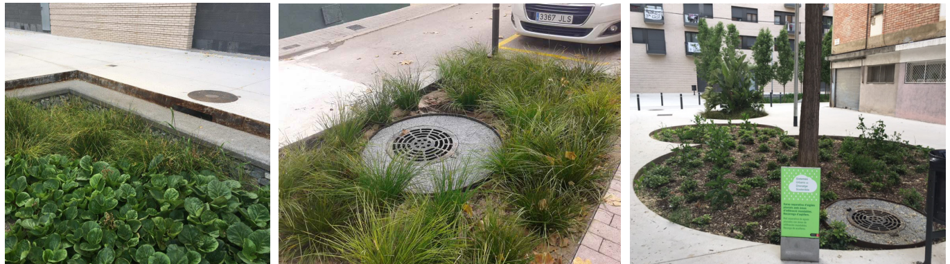
Figura 6. Detalle de sumidero en calzada conectado a los parterres inundables ajardinados.
