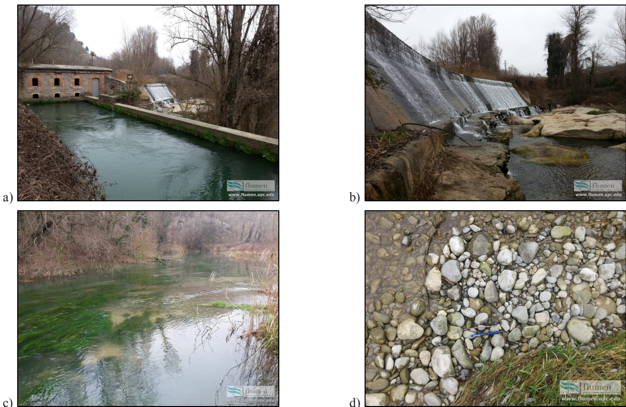
Figura 3 | Detalle del estado actual de la presa: a) canal de entrega de la mini-central; b) cuerpo de presa (órgano de desagüe situado en la margen izquierda y descalce de los cimientos); c) estado de sedimentación en el reservorio; y d) tamaño del sedimento situado aguas abajo.
