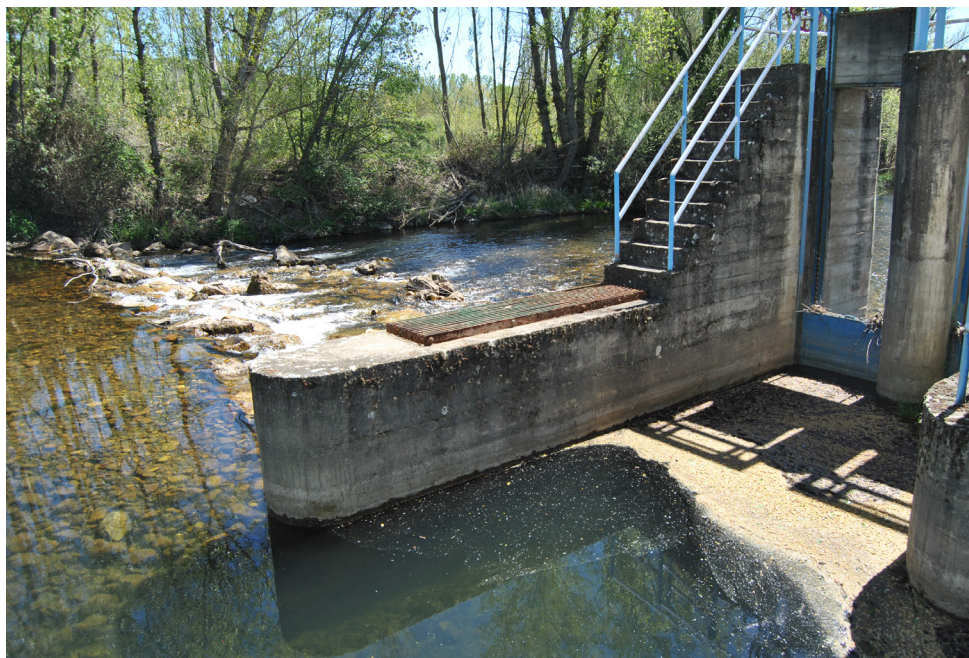
Figura 7 | Salida de la canalización al río, detalle de las compuertas.
