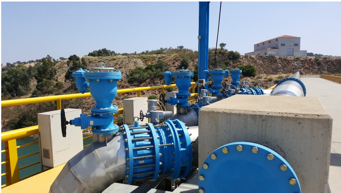
Figura 4 | Estación de bombeo que toma el agua del Embalse del Andévalo (Huelva)
