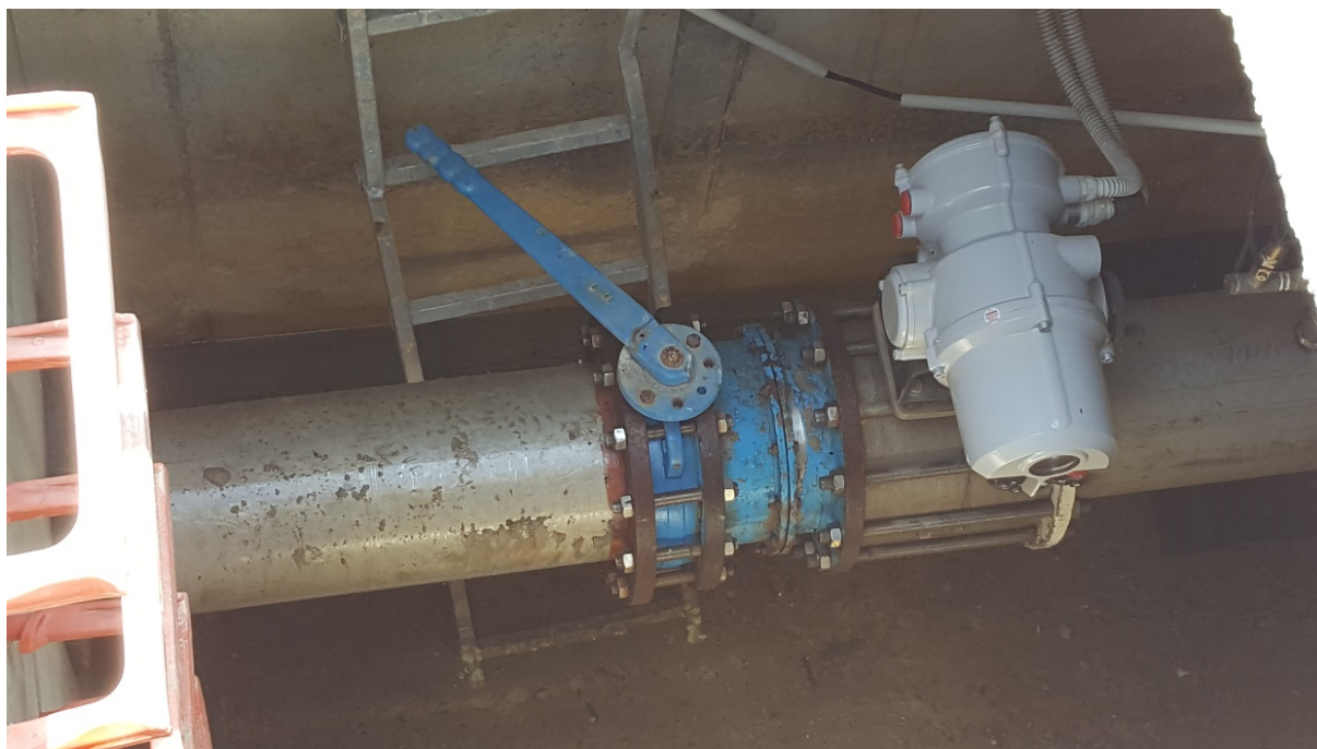
Figura 2 | Válvula reguladora eléctrica DN300 multichorro (Multinar) que controla el caudal de entrada a la ETAP de Puebla de Guzmán (Huelva)
