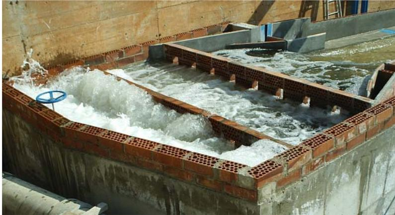
Figura 5 Depósito de cabecera de la plataforma.
