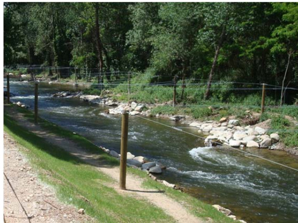
Figura 4 Vista de los deflectores ya construidos, el camino perimetral y los soportes de madera para la puertas de eslalon.
