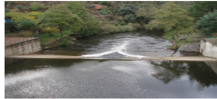
Figura 1 Imágenes de la estación de aforo V-Flat modelizada
