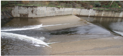
Figura 1 Imágenes de la estación de aforo V-Flat modelizada
