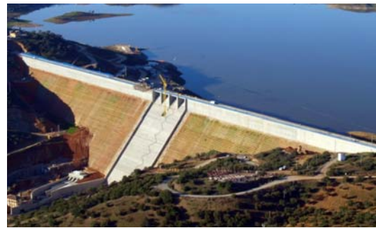
Ilustración 1. Presa de La Breña II.
