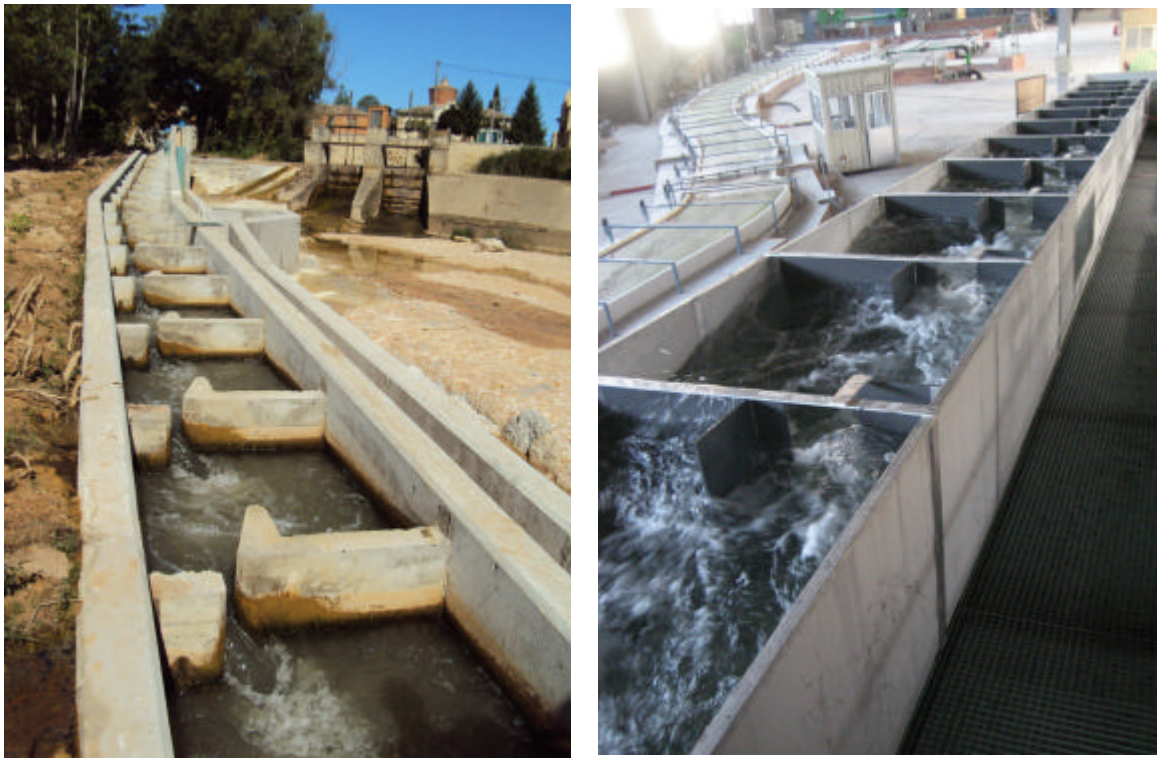
Figura 1 Escala de peces en la naturaleza con un canal de nado adosado (central de Vadocondes, CH Duero) y escala de peces en laboratorio de hidráulica del CEDEX. Infraestructuras necesarias para evaluar el efecto barrera de las obras hidráulicas
