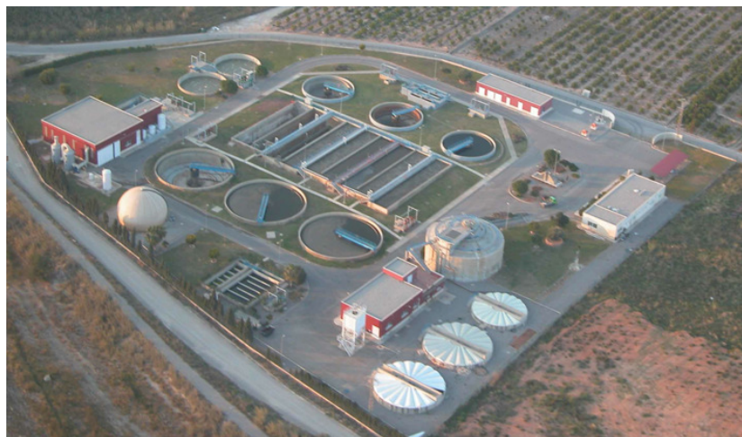
Figura 1 Vista aérea de la EDAR de Almassora.
