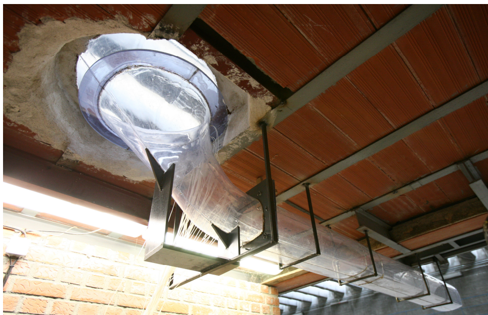
Figura 13 Vista inferior codo de salida y túnel de descarga
