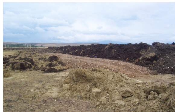
Figura 8 Diques de cierre ya cubiertos por tierra vegetal
