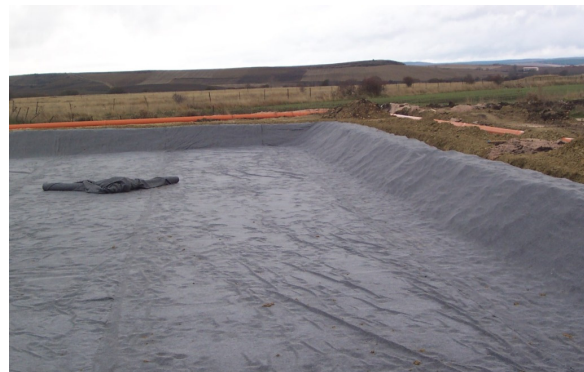
Figura 4 Impermeabilización de una de las balsas de depuración
